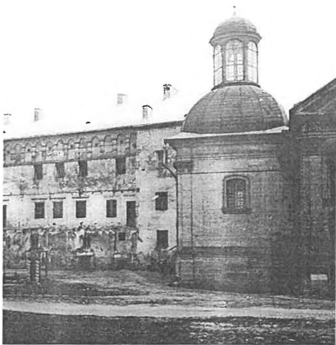
Zamek. Zniszczenia po 1918 r., część płd. od str. dziedzińca, zbiory CAW, nr. 232
