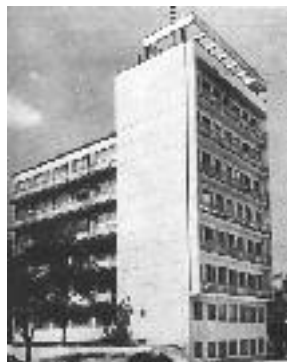
L. Paradista, dom przy ul. Sewerynow 4, 1937, stan sprzed 1939, fot. „Arkady” 1938 nr 12
