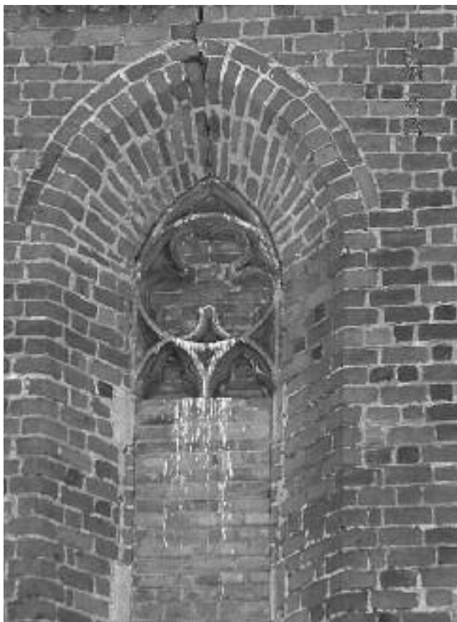
Nowy Korczyn, kościół pw. św. Stanisława – widok okna w nawie od strony północnej, fot. autorka
