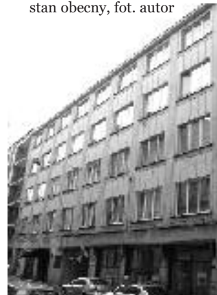
J. Gelbard, R. Sigalin, dom przy ul. Kredytowej 6, 1938, stan obecny, fot. autor
