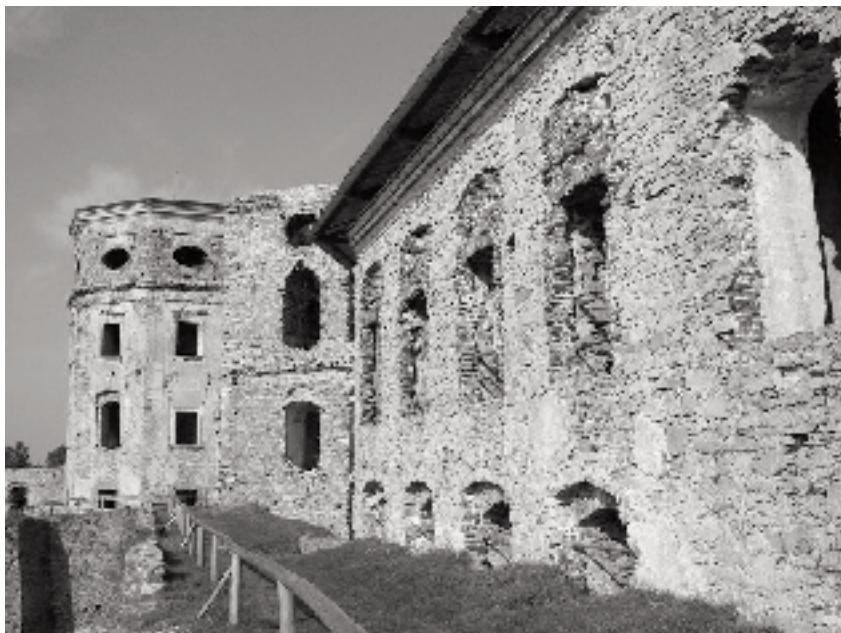
Widok ośmiobocznej wieży od strony zachodniej, Krzyżtopór, fot. K. Lędźwa, za stroną internetową: www.krzyztopor.org
