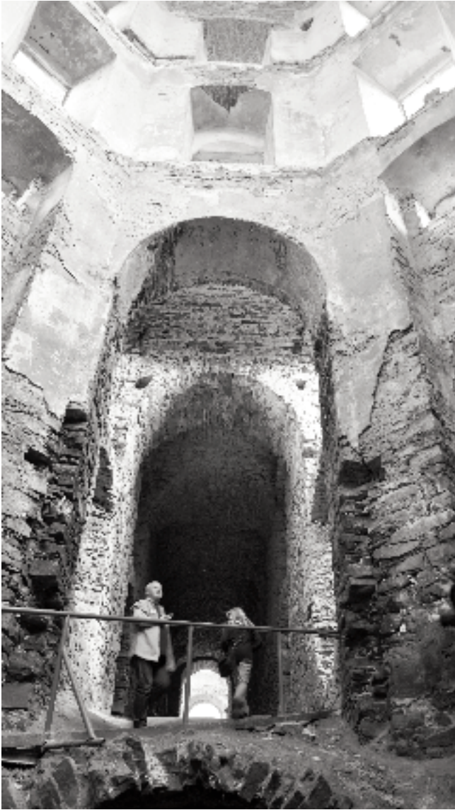
Widok wnętrza wieży z poziomu przyziemia, Krzyżtopór fot. T. Tolłoczko
