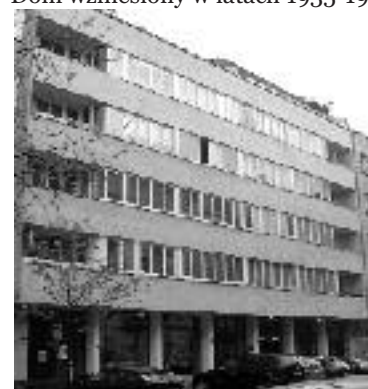
W. Weker, dom przy ul. Wiejskiej 14, 1935-1939, stan obecny, fot. autor
